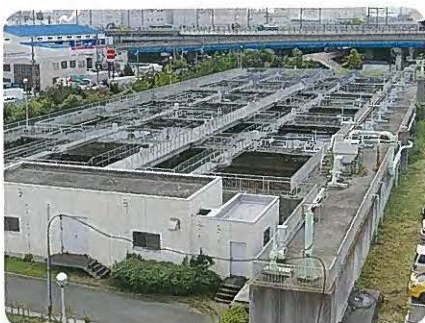
⑦雨天時汚水沈殿池
