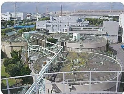
⑩ 汚泥消化タンク
