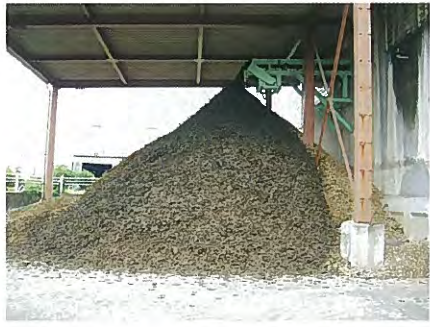
脱水ケーキヤード
